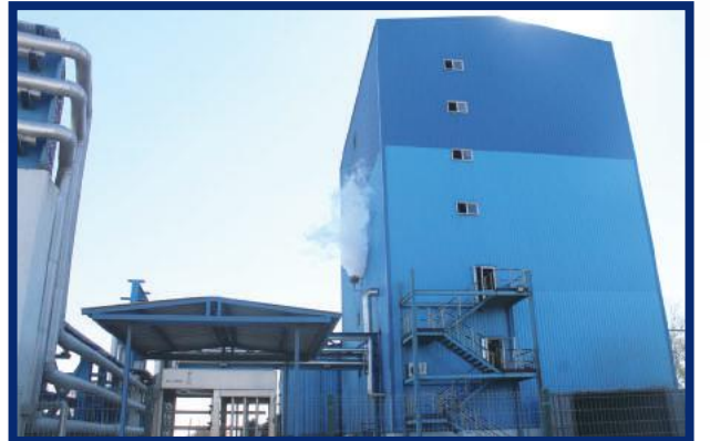
LİLA KAĞIT / ÇORLU 30 Ton/h 20 Barg 240 °C
